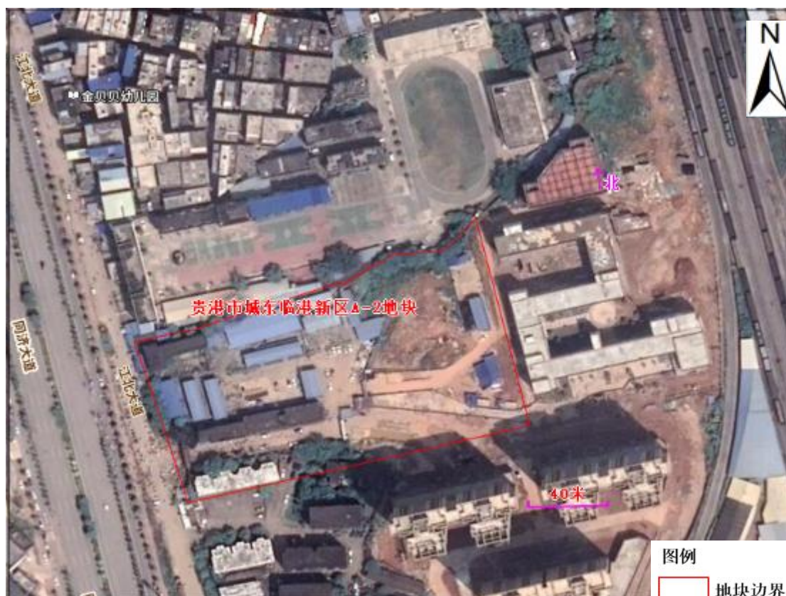
图 3.3-11 地块历史影像卫星图（2019 年 9 月 12 日）
