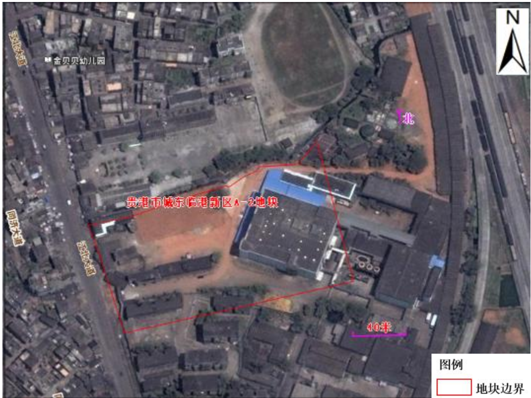
图 3.3-6 地块历史影像卫星图（2007 年 8 月 8 日）
