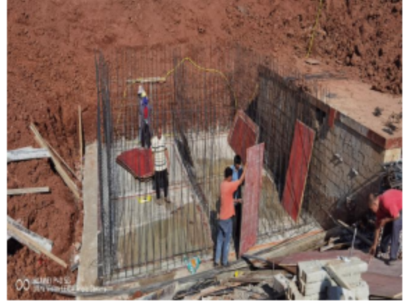
污水收集发酵池（兼初期雨水池）建设过程照片（现已建设完成埋于地下）
