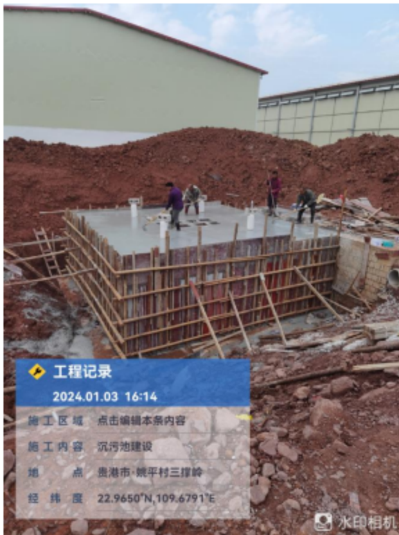
污水收集发酵池（兼初期雨水池）建设过程照片（现已建设完成埋于地下）
