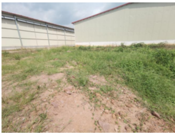
建好后埋于地下的污水收集发酵池（兼初期雨水池）
