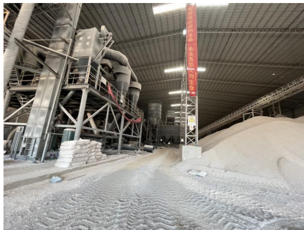
车间内部现状
