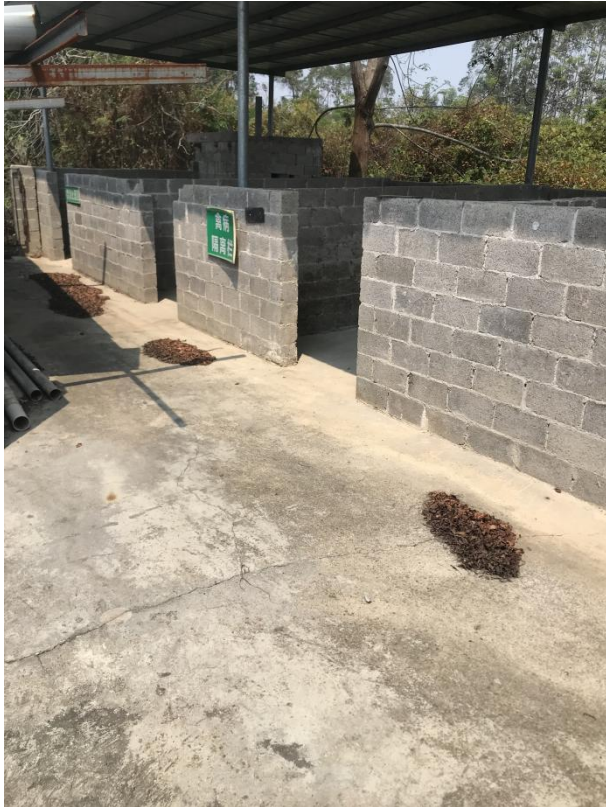
一般固废暂存间
