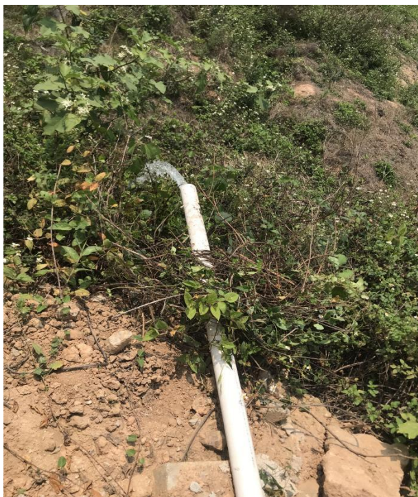
污水处理站排放口
