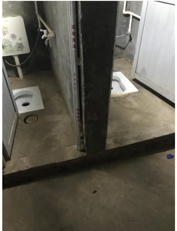
三级化粪池所在地
