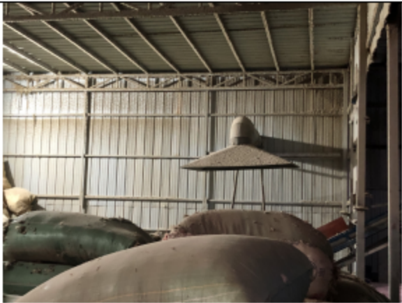
原料仓库及废气收集措施
