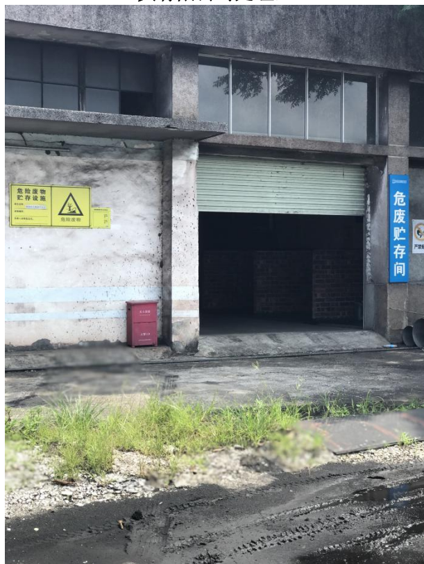
危废暂存间(外部, 单独分类收集、暂存于广西贵港北港国际集装箱码头有限公司作业区内现有危废间)
