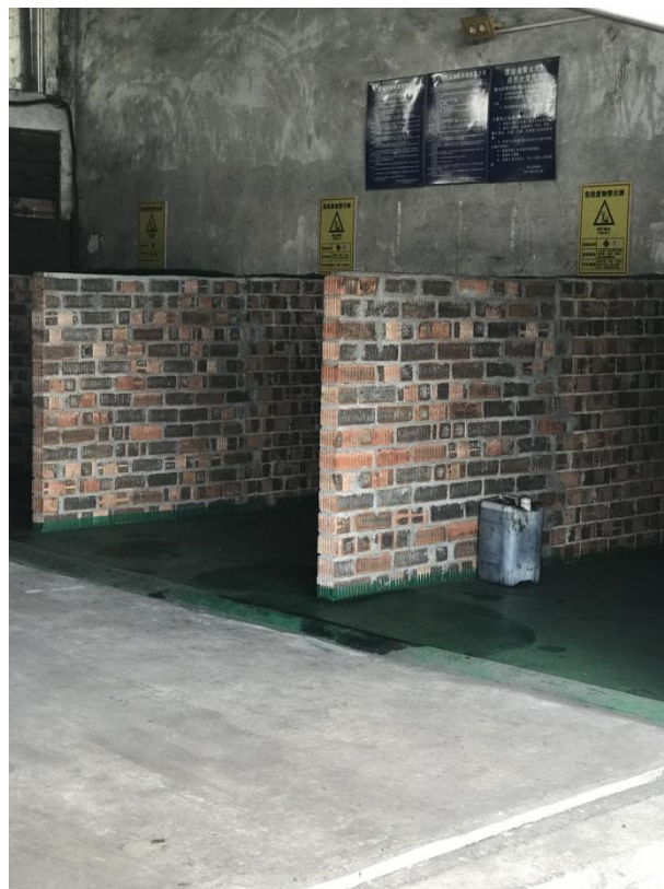
危废暂存间(内部, 单独分类收集、暂存于广西贵港北港国际集装箱码头有限公司作业区内现有危废间)
