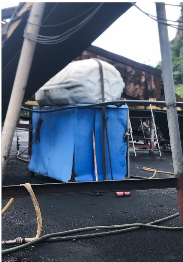
储水罐（喷淋用）
