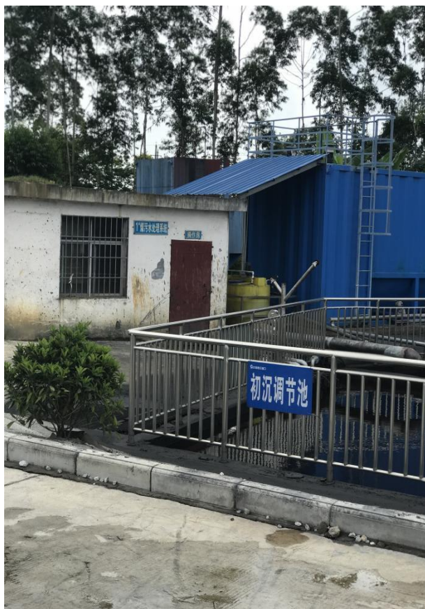
1#煤污水处理站(依托广西贵港北港国际集装箱码头有限公司处理)
