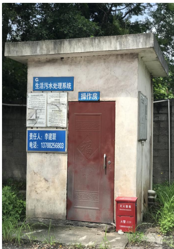
生活污水处理站(依托广西贵港北港国际集装箱码头有限公司处理)
