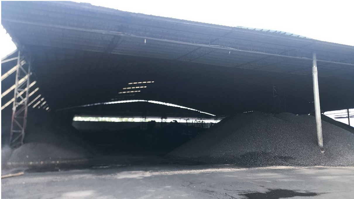
堆场（加盖顶棚+地面硬化）
