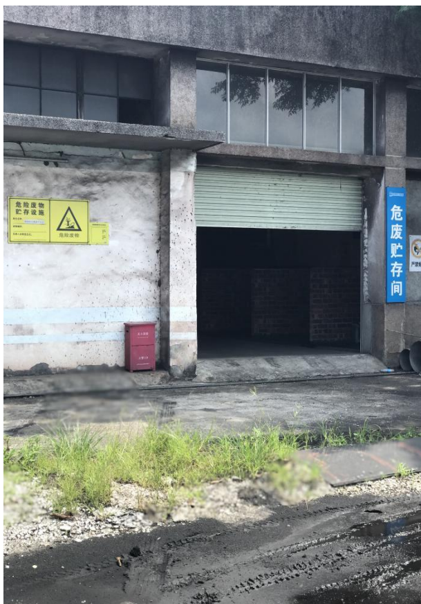
危废暂存间（外部，单独分类收集、暂存于广西贵港北港国际集装箱码头有限公司作业区内现有危废间）
