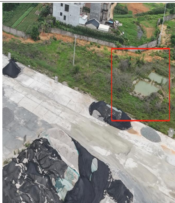
生产污水处理站
