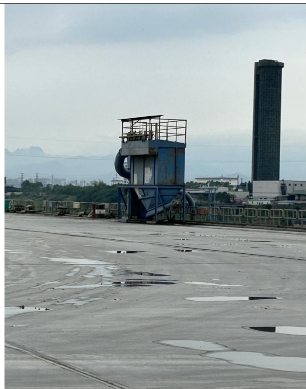
布袋除尘器（收集装卸散货粉尘）
