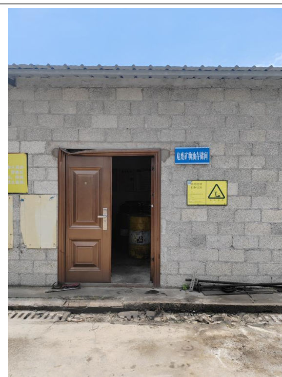
危废暂存间（外部）
