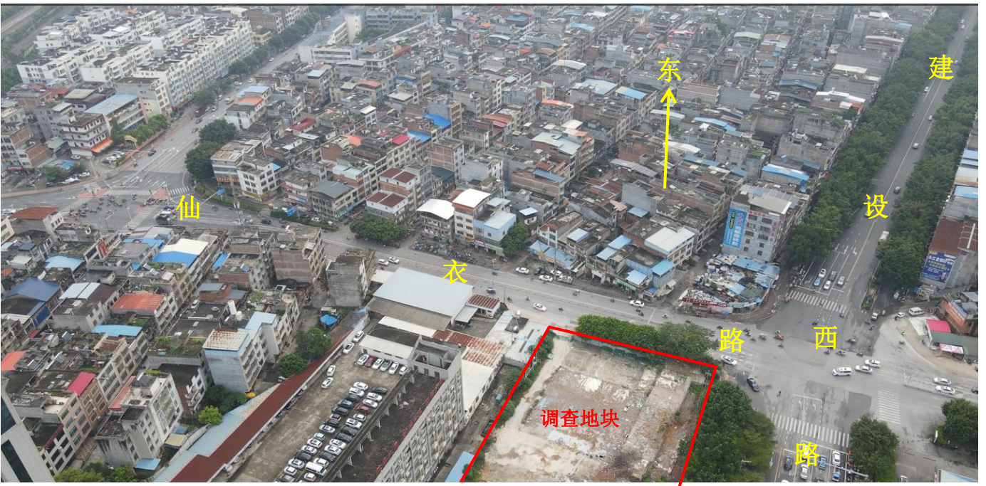
图 3-4 地块东面现状
