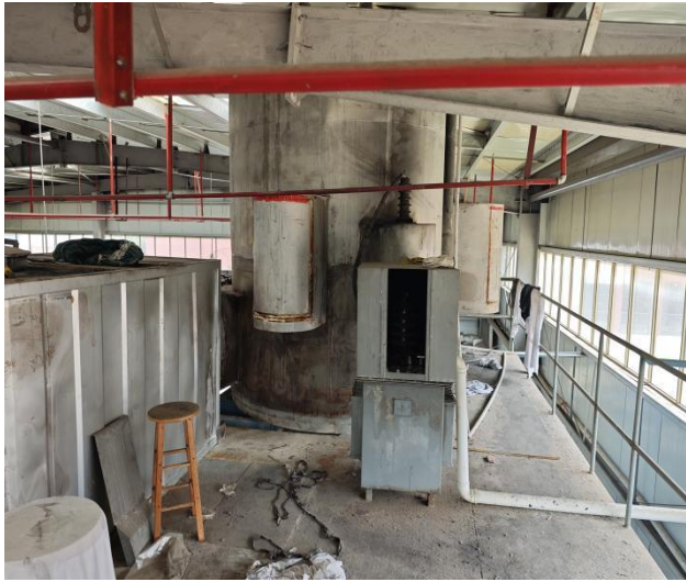
定型废气处理措施（除尘设备+排气筒）
