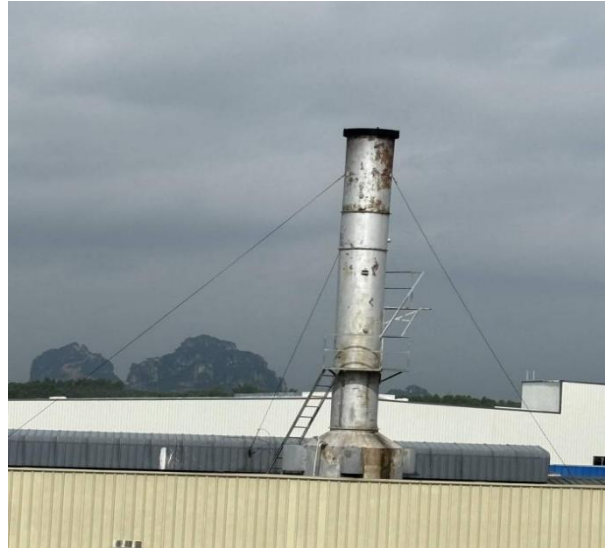
定型废气处理措施（除尘设备+排气筒）
