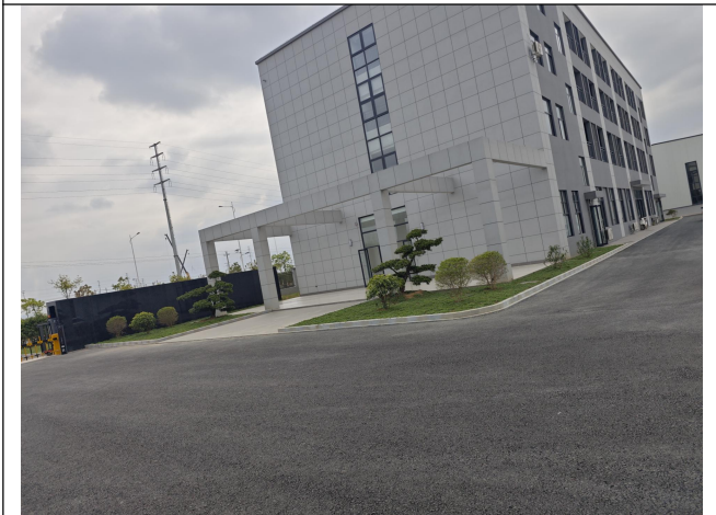
厂区进出口、办公楼旁 (已全部绿化+地面硬化) (2026.3.10)
