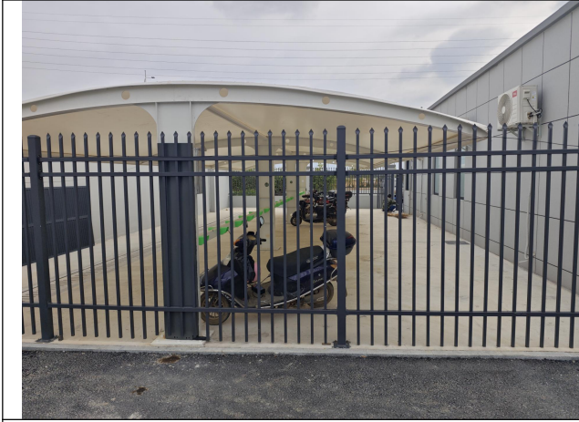
门卫室旁、停车场（原施工生产区，已全部硬化） (2026.3.10)
