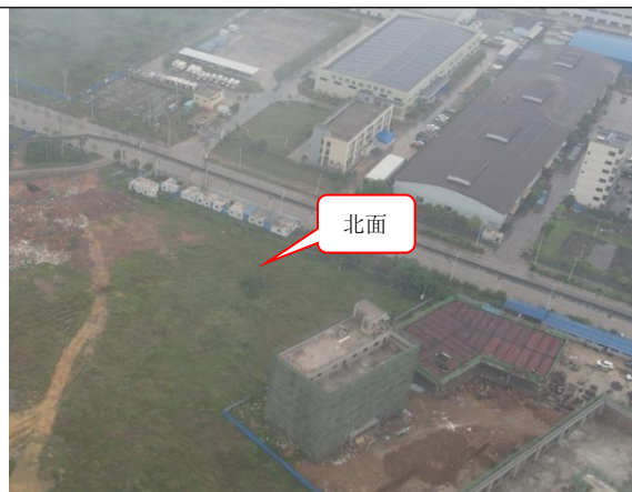
项目北面-荒草地 (2026年4月)
