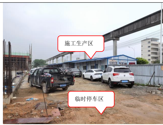
临时停车区及施工生产区 (2026年4月)
