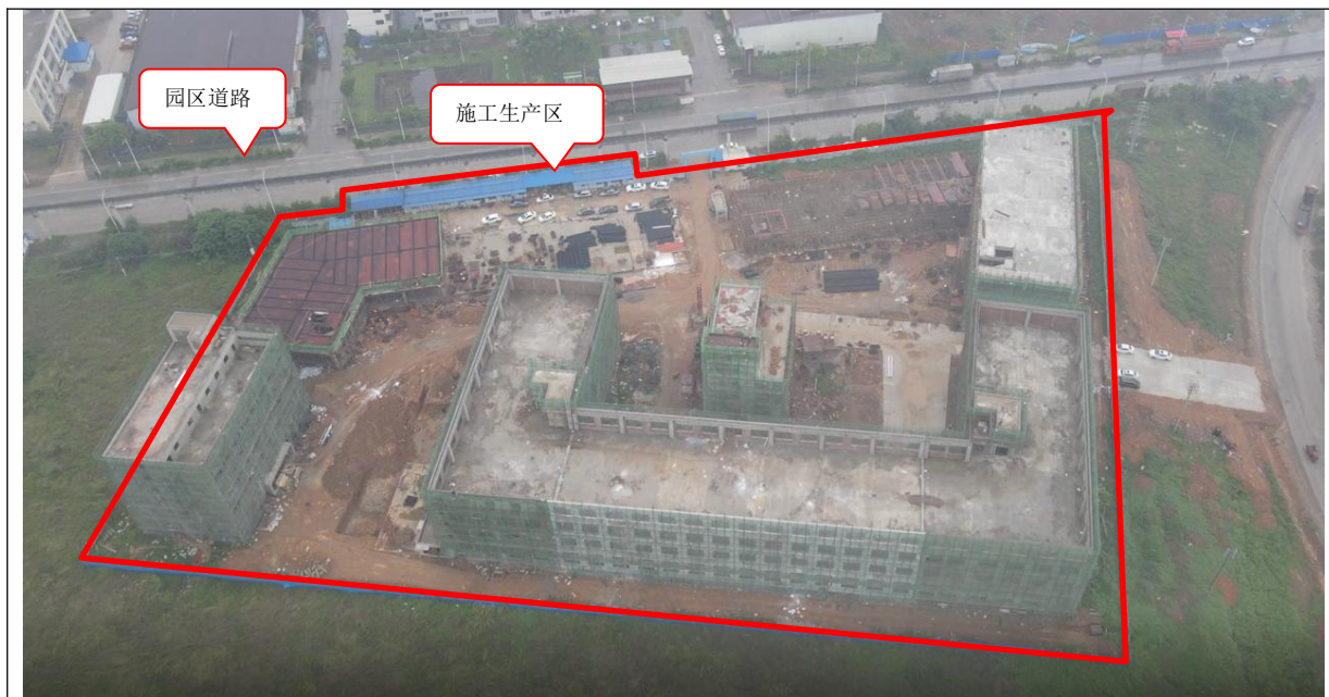
项目现状全景图 (2026年4月)
