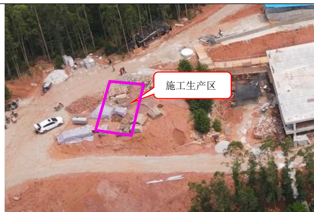
施工生产区 (2026年4月)
