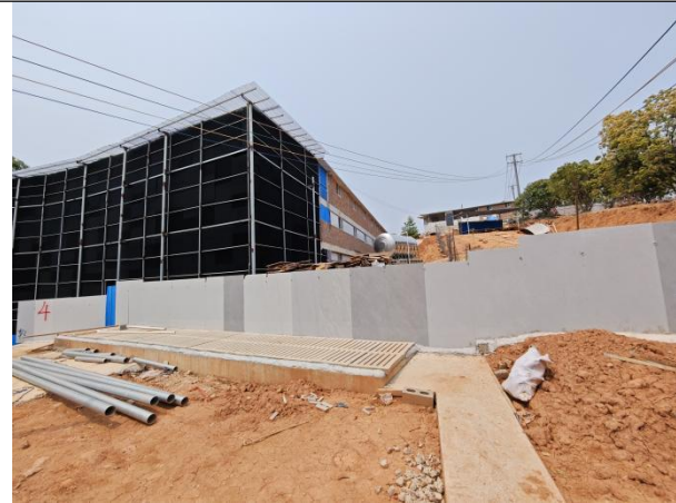
项目现状-已建育肥猪舍 (2026年4月)
