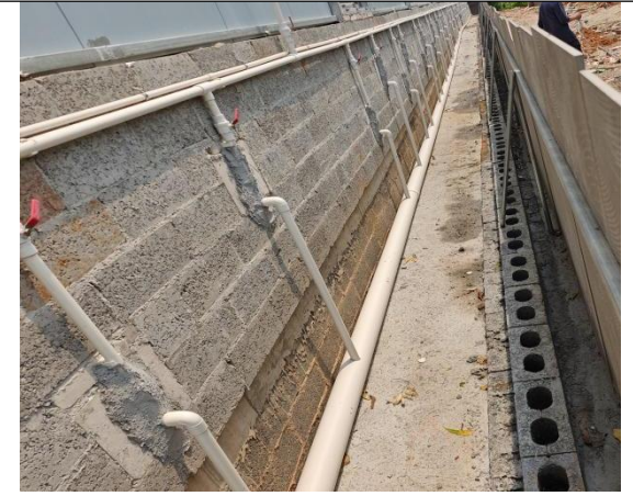
育肥猪舍周边排水沟 (2026年4月)
