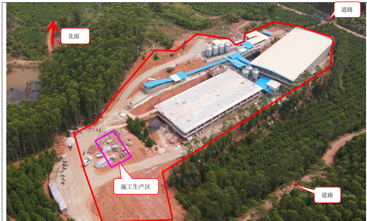
项目现状-全景图 (2026年4月)
