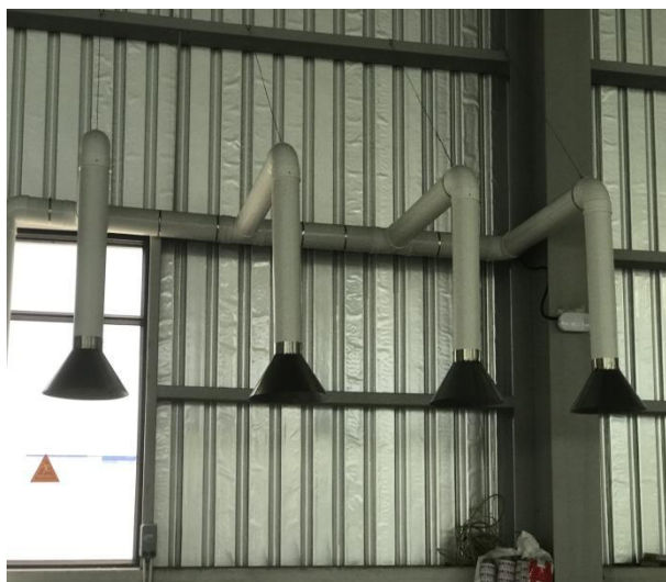
集气罩（打胶废气处理）
