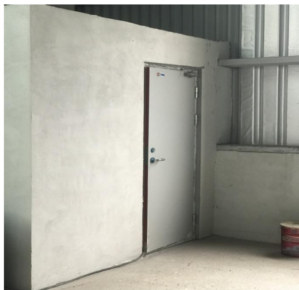
一般固废暂存间
