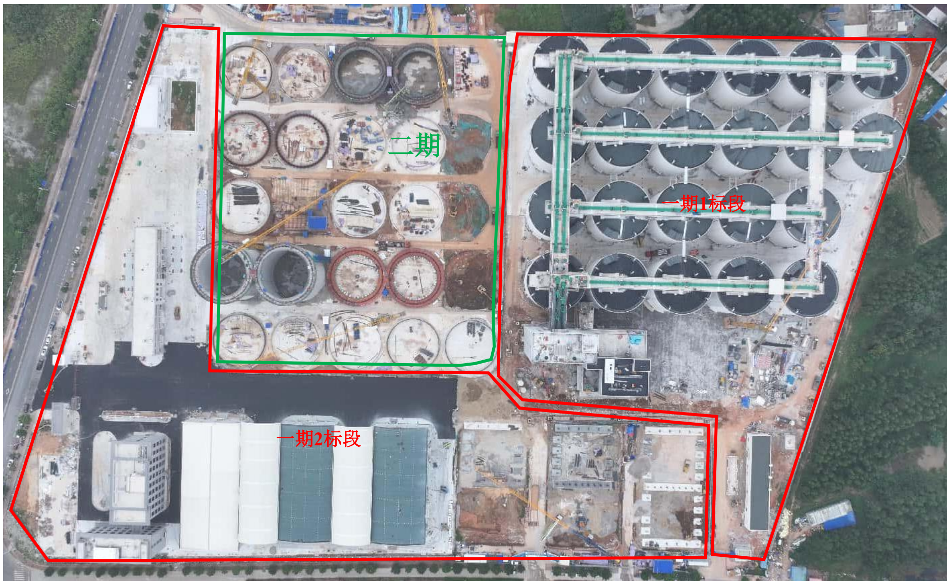
图1-1项目厂区施工现状全貌（2026年9月）
