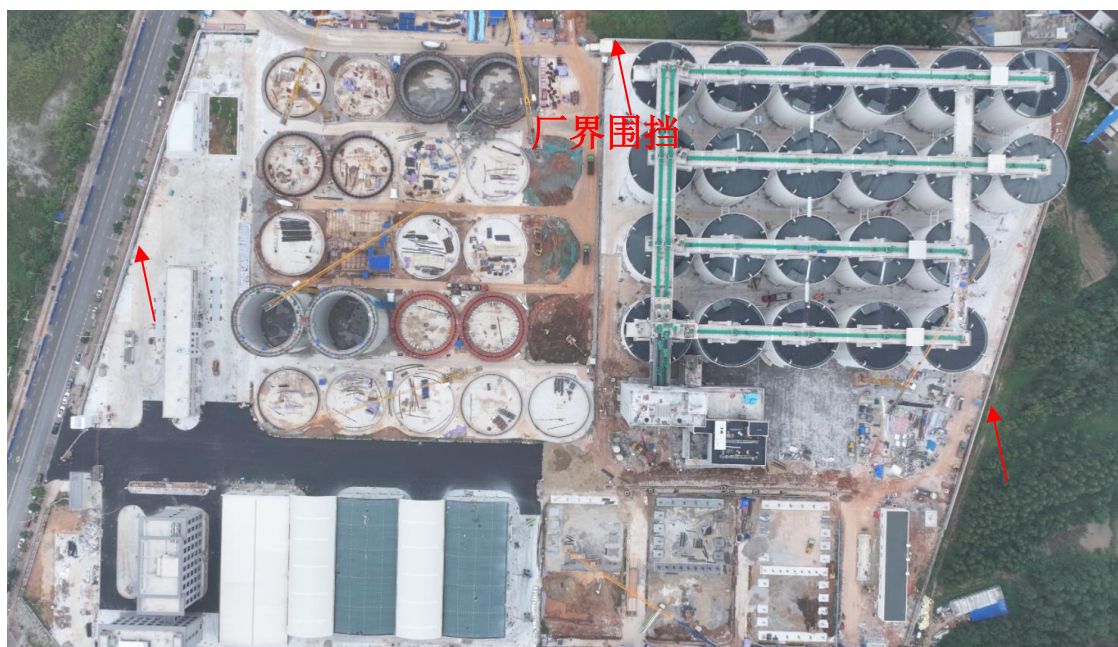
图3.6-1施工厂界围挡
