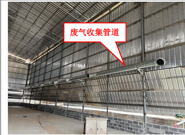
打磨除锈车间
