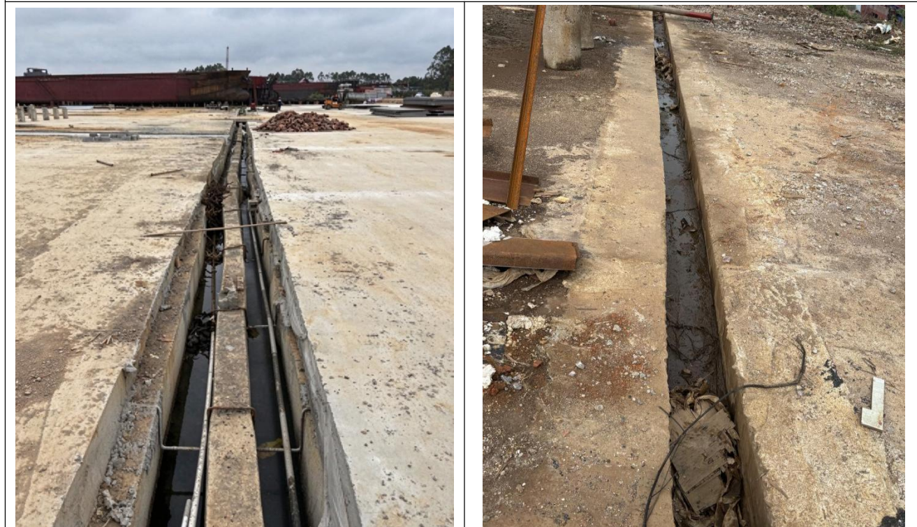
厂区周围雨水沟（截流措施）
