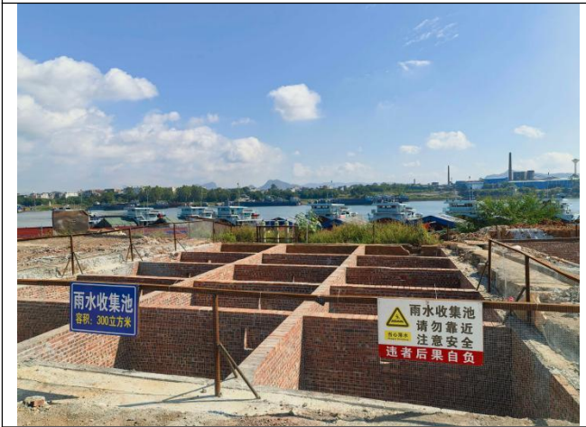
初期雨水收集池
